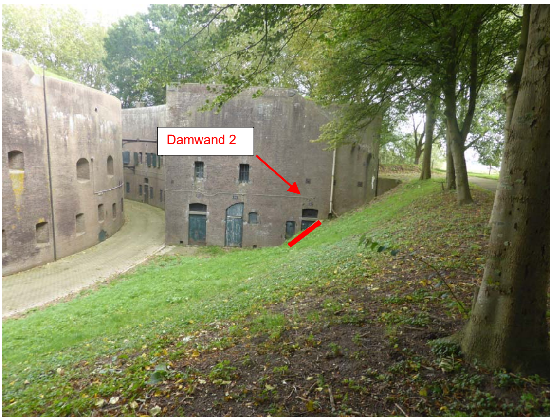
Figuur 6—2: Binnentalud grondwal met locatie damwand 2
