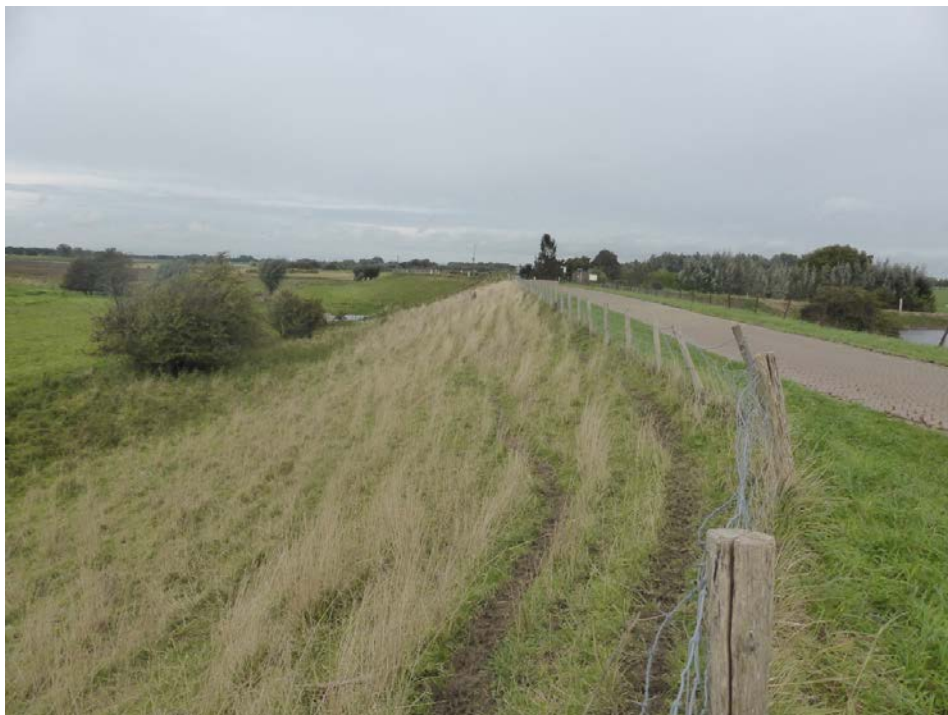
Figuur 8.18: Groene dijk met toegangsweg naar Fort Honswijk
